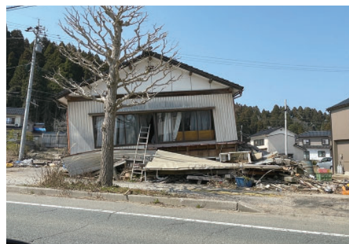
倒壊したままの家屋
