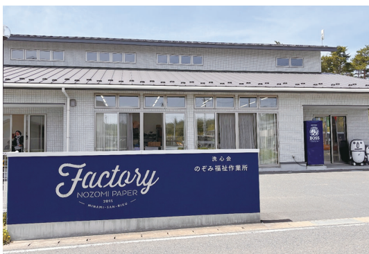
のぞみ福祉作業所の外観
