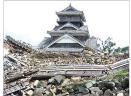
熊本地震で石垣が倒壊した熊本城
